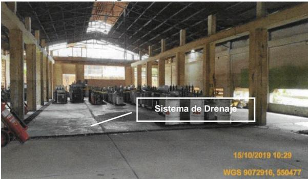
Imagen 04. Almacén central Bellavista con drenaje y bandeja de contención
