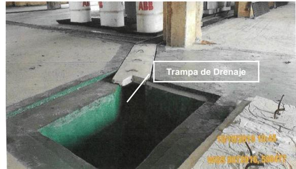
Imagen 07. Trampa de drenaje impermeabilizada con pintura epóxica
