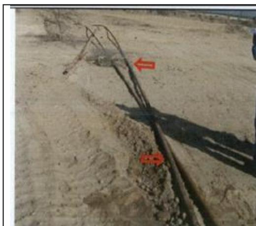
Fotografía N°1: Se observa que la tubería reparada se encuentra en contacto directo con el suelo natural.
