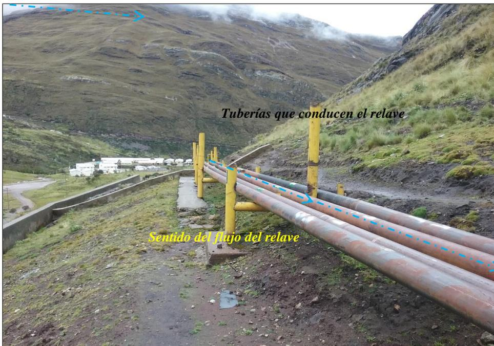
**Fotografía N° 38.** Revestimiento del área de la tubería de transporte de relave: Se observa parte del tramo 2, el área por donde se ubica la tubería que transporta el relave no cuenta con un revestimiento que impida el contacto entre posibles fugas.
