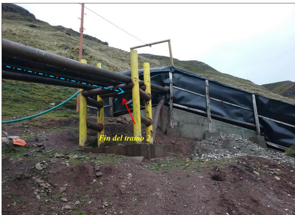
**Fotografía N° 39.** Revestimiento del área de la tubería de transporte de relave: Se observa el punto inicial del tramo 2, el área por donde se ubica la tubería que transporta el relave no cuenta con un revestimiento que impida el contacto entre posibles fugas.
