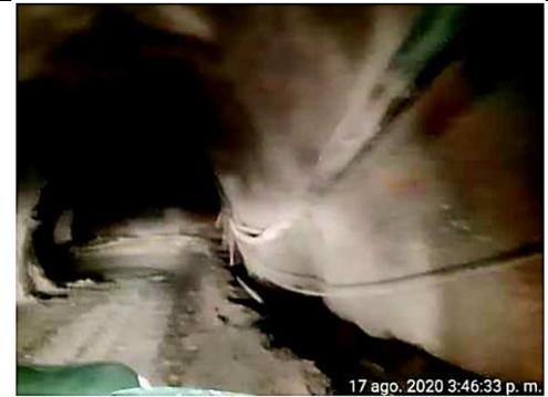
Fotografía N° 16: Tubería HDPE 4" (Nv. 3720) por rampa 990 hacia Chimenea 2 (Nv. 3660).
