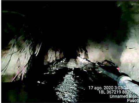
Fotografía N° 9: Tubería HDPE 4" desde Poza de paso 1 (Nv. 4050) hacia Poza de paso 2.
