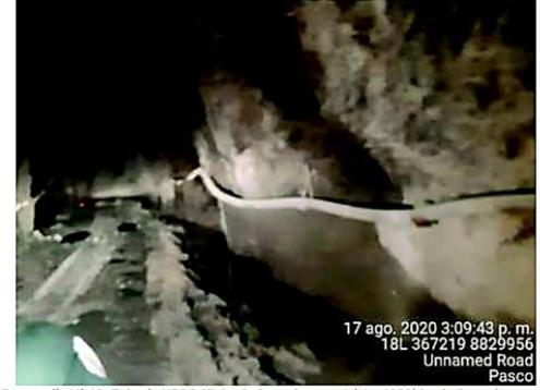
Fotografía N° 12: Tubería HDPE 4" desde Poza de paso 1 (Nv. 4050) hacia Poza de paso 2.
