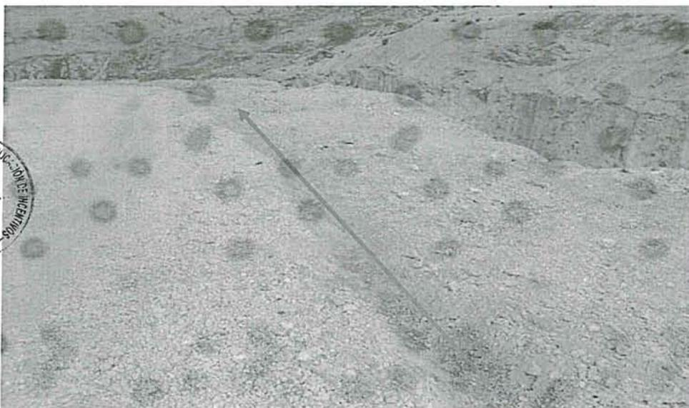
Foto 74: Vista del relleno sanitario con canal de derivación de agua de lluvia fuera de medida, no cumplen con lo recomendado en el diseño.
