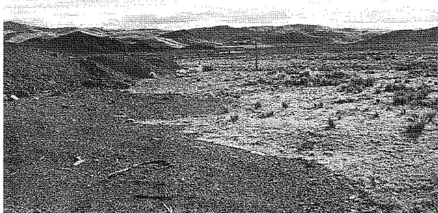
Fotografía N° 21.- Depósito de desmonte de mina – el material se deposita directamente sobre suelo natural.
