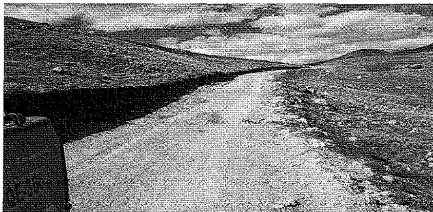
Fotografía N° 05.- Carretera entre campamento y bocaminas, riplada con material de desmonte de mina.
