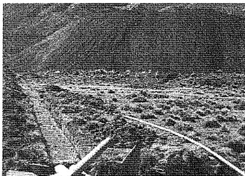
FOTO N° 57: Zanjas de conducción de aguas de drenaje ácido.
