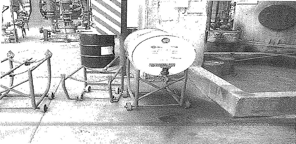
Figura N° 5. Sistema de dosificación de reactivos químicos. Se aprecia goteo y riesgo de derrame de producto.
