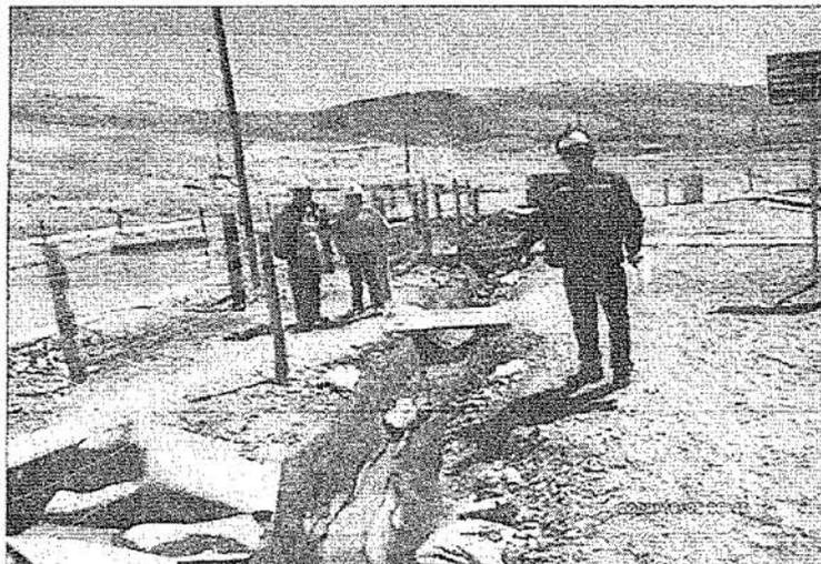
Fotografía N° 82. Poza y sistema de canales de conducción de aguas de Mina en el Nivel 4600, sin la impermeabilización adecuada.
