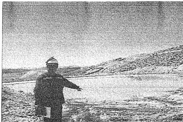
Fotografía N° 83: Poza de sedimentación en el Nivel 4600, sin la implementación adecuada, no se ajusta a diseño aprobado en EIA.
