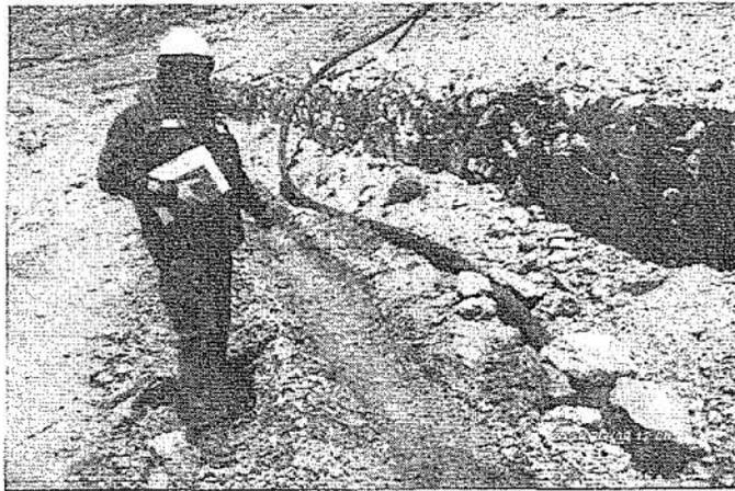
Fotografía N° 90: Depósito de Mineral.- Captación y conducción de drenaje del depósito de mineral que conduce hacia las pozas de tratamientos de aguas de mina, excavado en suelo, sin impermeabilización.
