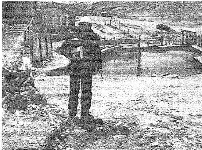
Fotografía N° 91: Conducción de drenaje del depósito de mineral hacia las pozas de tratamiento de aguas de mina.
