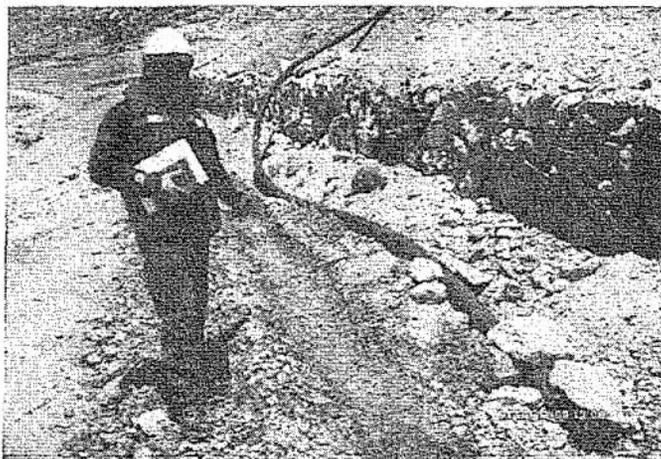
Fotografía N° 90: Depósito de Mineral.- Captación y conducción de drenaje del depósito de mineral que conduce hacia las pozas de tratamientos de aguas de mina, excavado en suelo, sin impermeabilización.
