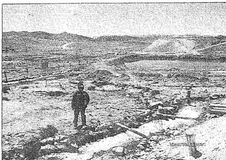
Fotografía N° 84: Poza de sedimentación en el Nivel 4600 y canales de conducción de solución sin la implementación adecuada, no se ajusta a diseño aprobado en EIA.
