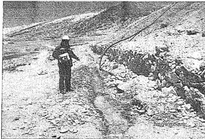
Fotografía N° 89: Depósito de Mineral.- Captación y conducción de drenaje del depósito de mineral que conduce hacia las pozas de tratamientos de aguas de mina, excavado en suelo, sin impermeabilización.
