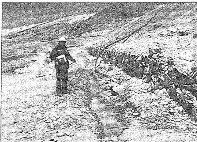
Fotografía N° 89: Depósito de Mineral.- Captación y conducción de drenaje del depósito de mineral que conduce hacia las pozas de tratamientos de aguas de mina, excavado en suelo, sin impermeabilización.
