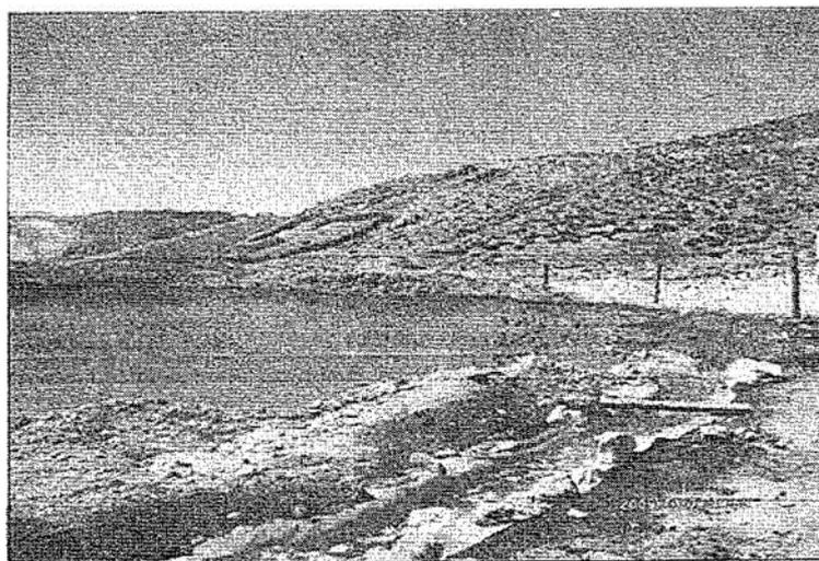
Fotografía N° 86: Otra vista de poza de sedimentación en el Nivel 4600 y canal de conducción de solución sin la implementación adecuada
