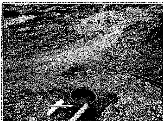
Fotografía N° 87 descarga de efluente de trampa de grasas de taller de mantenimiento mecánico de contratistas hacia el medio ambiente, discurre por la vía y llega al Stock Pile, Recomendación N° 17, UEA Vinchos.
