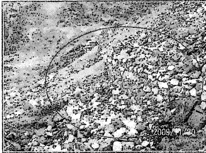
Fotografía N° 108: Muro de contención colapsado de la cancha de mineral Stock Pile, impactando el medio natural de pastizales tipo césped de puna, Recomendación N° 7, UEA Vinchos.
