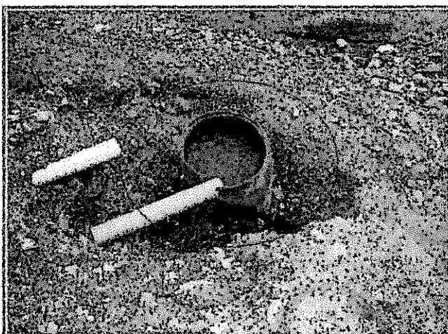
Fotografía N° 86: descarga de efluente de trampa de grasas de taller de mantenimiento mecánico de contratistas hacia el medio ambiente, Recomendación N° 17, UEA Vinchos.
