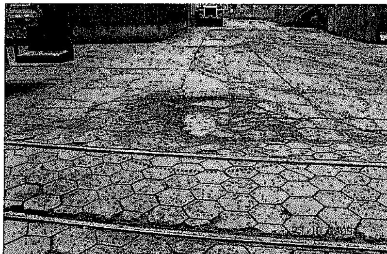
FOTO N° II.13.9 (Obs.1, 2009) : Losas deterioradas, con depresiones cerca de salida de depósito de plomo
