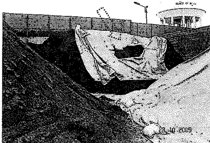
FOTO N° II.14.3 (Obs.3, 2009): Mantas cobertoras deterioradas, rotas y de tamaño insuficiente en depósitos de zinc y cobre.
