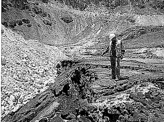
Fotografía N°14.- Desmonte Estela, se observa desplazamiento y grietas en el bofedal generado por la presión que ejerce el desmonte.
