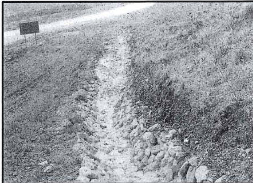
Fotografía N° 23: Otra parte del canal construido de piedra por donde son evacuadas las aguas acumuladas de la Planta de Chancado (Gold Mill), lleno de sedimentos.
