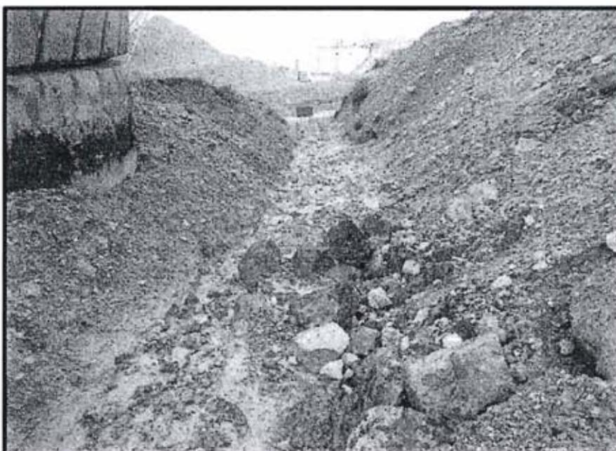
**Fotografía N° 22:** Canal construido sobre tierra por donde son evacuadas las aguas acumuladas de la Planta de Chancado (Gold Mill), lleno de rocas y sedimentos.
