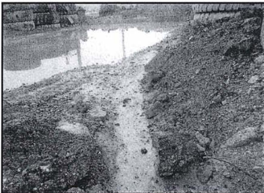
**Fotografía N° 21:** En la Planta de Chancado (Gold Mill), se aprecian aguas acumuladas que son derivadas hacia un canal construido sobre tierra.
