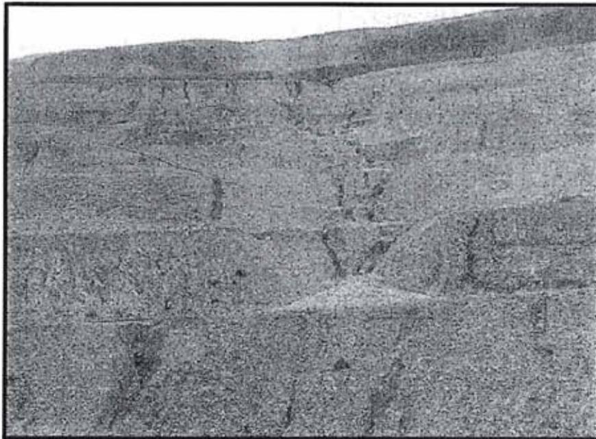
Fotografía N° 19: En la Pila de Lixiviación La Quinua (Etapa N° 1), en los bancos N° 1, 2 y 3, se observa erosión por las aguas de lluvia.
