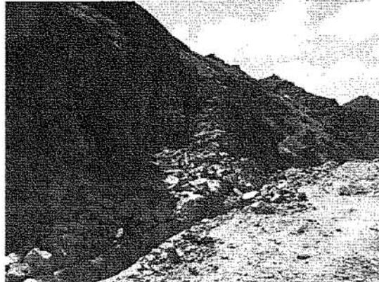
51. La obstrucción del canal de coronación (que se encuentra en la parte superior del depósito de desmonte Codiciada) puede ocasionar el rebalse de las aguas que transcurren en él, las mismas que, al entrar en contacto con el material piritoso del depósito de desmonte, pueden generar drenaje ácido de roca, constituyendo una situación contaminante para el ambiente.
