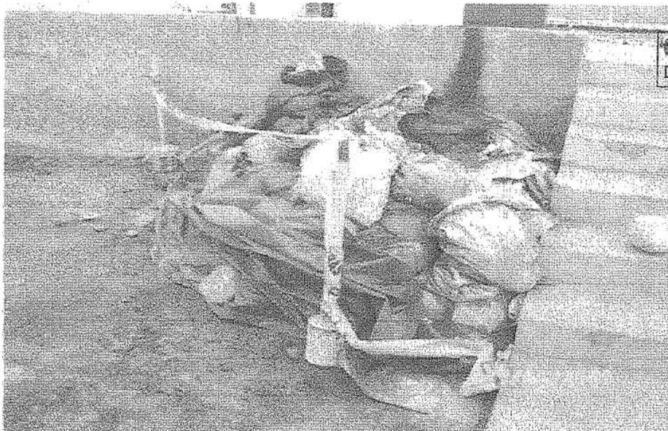
Figura N° 11. Se aprecia granalla contaminada dispuesta inadecuadamente y mal protegida contra la lluvia y el viento.
