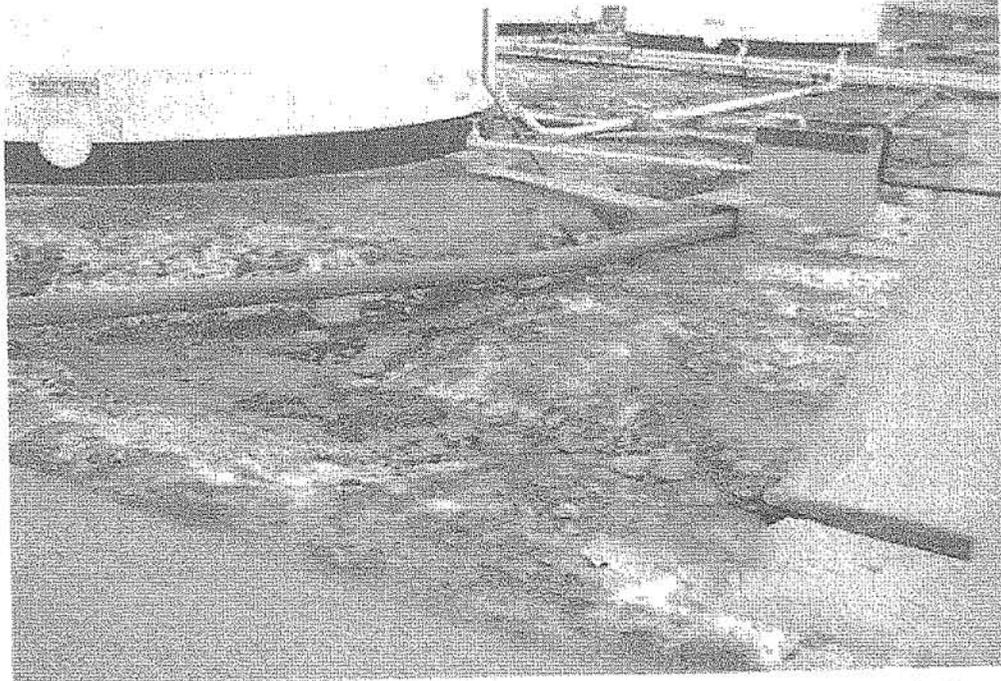
Figura N° 2. Se aprecia la zona estanca del tanque de gasolina con el suelo contaminado con sal y la napa freática a nivel del suelo.
