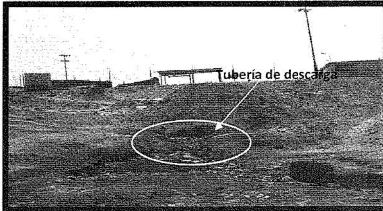
Foto N° 29: En el lado contiguo de la estación de bombas 3, componente del tratamiento de las aguas residuales domésticas (PTARD) de Marcona, se encuentra una tubería de descarga o purga del efluente.
