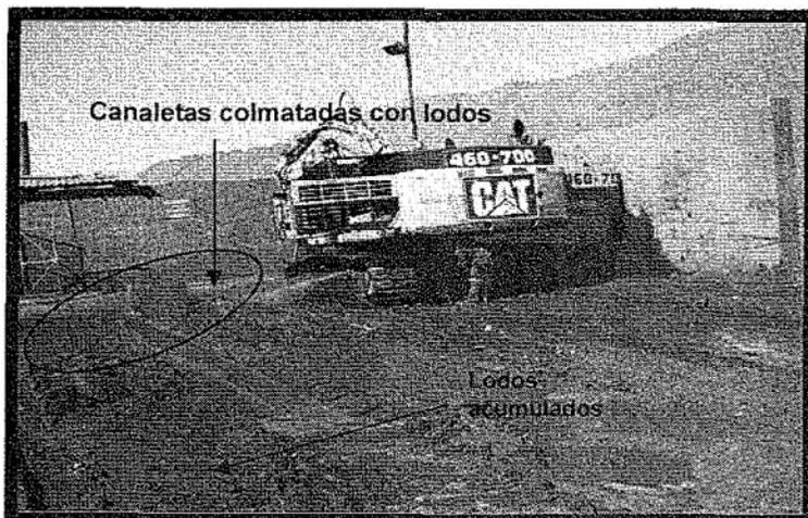
Foto N° 4: Lavadero de equipo pesado donde las canaletas que conducen las aguas producto del lavado encuentran colmatadas con lodos.
