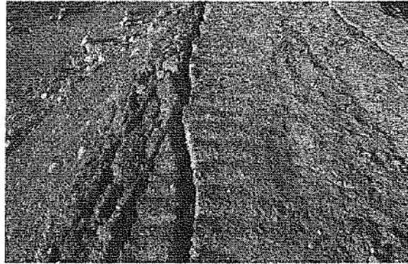
Fotografía N° 24: Rajaduras en la corona del dique de contención del depósito de relaves N° 2.
