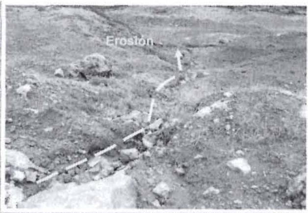
**Foto N° 14:** Erosión hídrica de las pilas de material en el banco inferior del tajo "Fase A".
