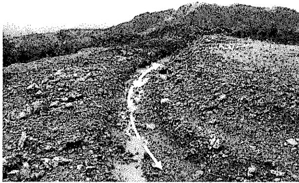
Foto N° 21: Vista de la falta de mantenimiento de los canales de coronación del tajo, debido a la colmatación de estas estructuras, interrumpiendo el flujo del agua de escorrentía.
