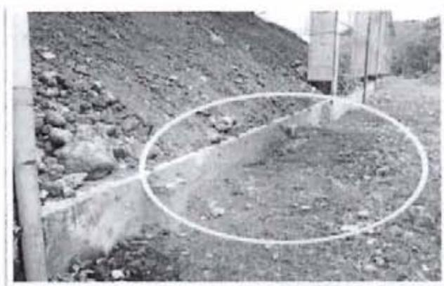
**Foto N° 17:** Naves de las tres áreas del almacén temporal de mineral (A, B y C), se ha evidenciado presencia de derrame de minerales sobre los muros de los depósitos, apilamiento excesivo, altura de muros insuficiente, presencia de minerales fuera del área de los depósitos (hangares) del área de secado.
