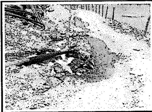
Foto N° 27: Canal deteriorado aguas debajo de la casa de bombas que origina deficiencias en la conducción de efluente minero a la poza de sedimentación.
