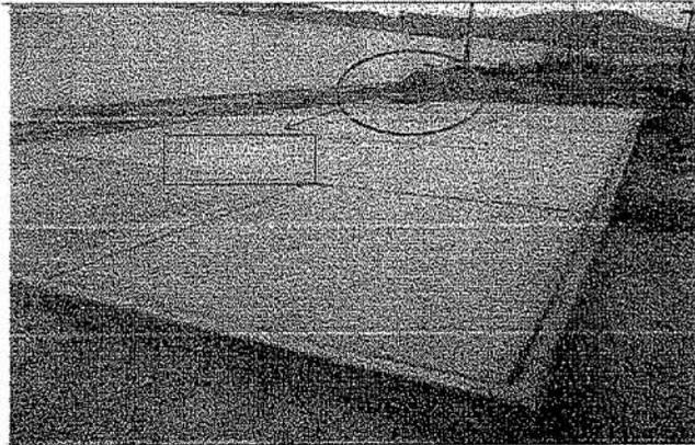
N° 131 En la S.E.T Pampa Inalámbrica - Ilo, ya se ha construido la losa de concreto y el tanque de contención en caso se produzca un escape accidental de líquidos peligrosos (aceite dieléctrico, agua contra incendio, etc.) del depósito de materiales peligrosos
