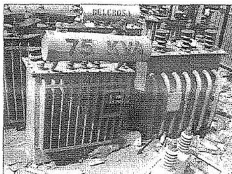
Foto N°13 Almacén Ilo: Transformadores ubicados a la intemperie, sobre superficie permeable.
